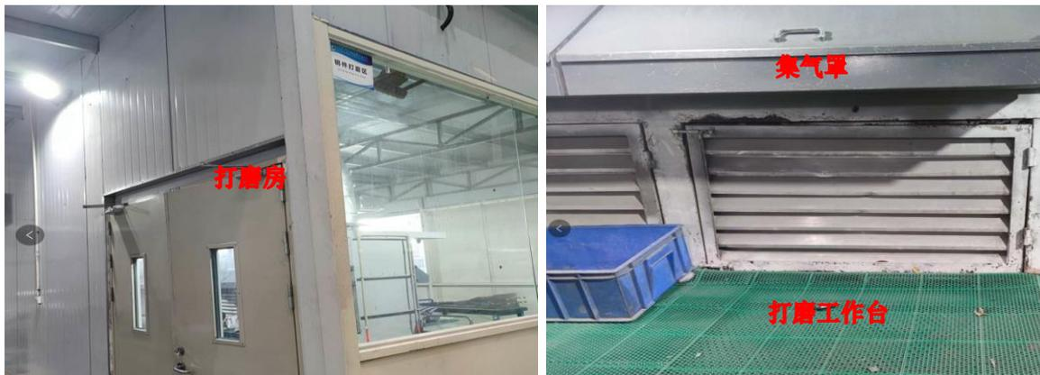
图 4.4-4 爱乐达航空零部件科研、生产及检测项目打磨废气收集处置情况
